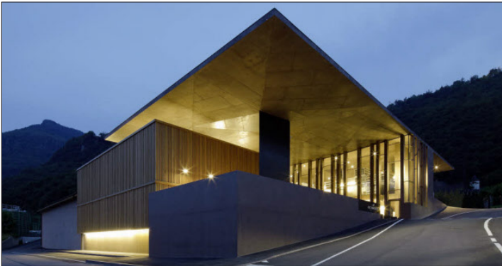
Kellerei Nals Margreid, Vordach Eingangsplatz
