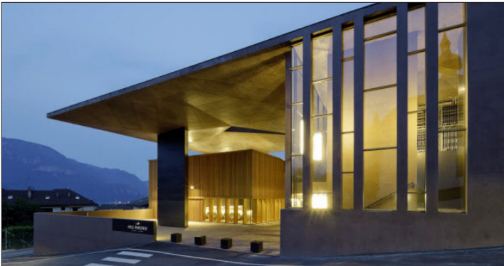
Kellerei Nals Margreid, Eingang mit Barriquekeller
